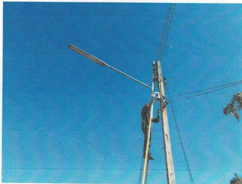
รูปภาพซ่อมแซมไฟฟ้าสองสว่าง
